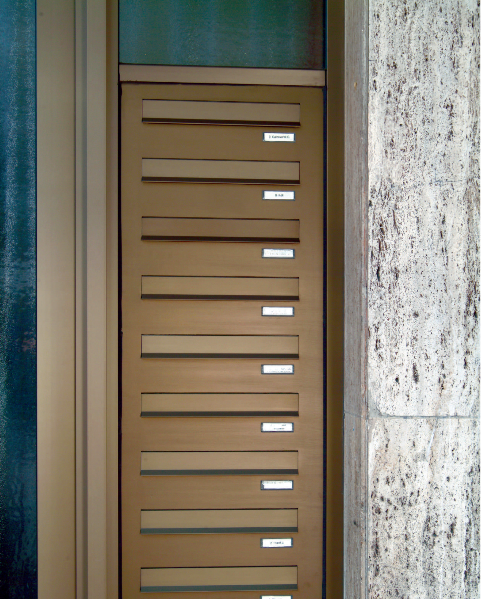
BRIEVENBUSGEHELEN – IN TE BOUWEN IN DE VASTE DEURVLEUGEL BOÎTES AUX LETTRES – POSE À TRAVERS LE VANTAIL FIXE
