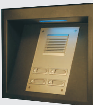
VOORBEELD 5: ANTI-VANDALISME ALUMINIUM BELKNOPPEN - ROOSTER VOOR PARLOFONIE IN ALU-PROFIEL - SCHUIN VAK MET DIRECTE VERLICHTING
